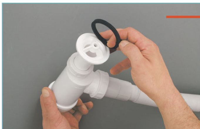
6 Кладем уплотнительное кольцо на верх погружной трубки сифона.
