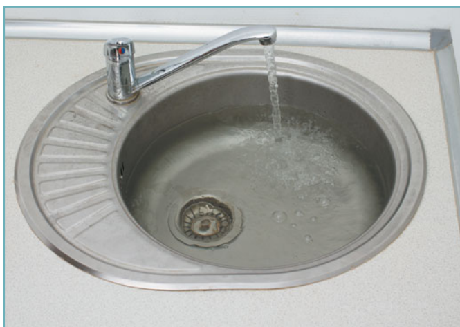
7 Пускаем в мойку воду для проверки герметичности соединений (выпуск из мойки закрываем).
