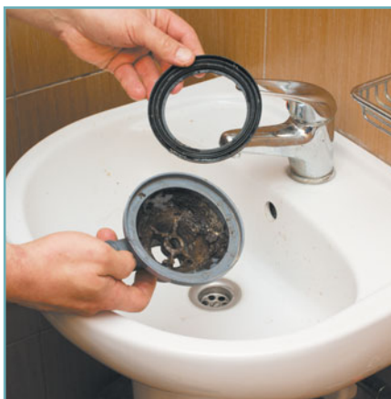
8 Снимаем и промываем уплотнительное кольцо дна сифона.
