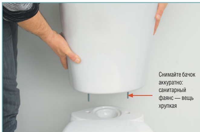
7 Аккуратно снимаем бачок с полки унитаза.
