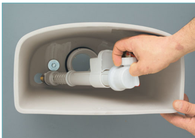
10 Вынимаем поплавковый клапан.
