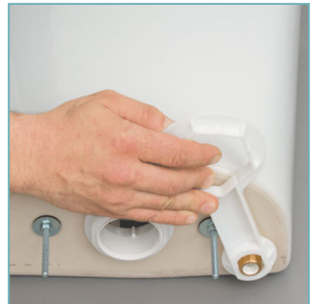
17 Затягиваем гайку специальным ключом до упора.
