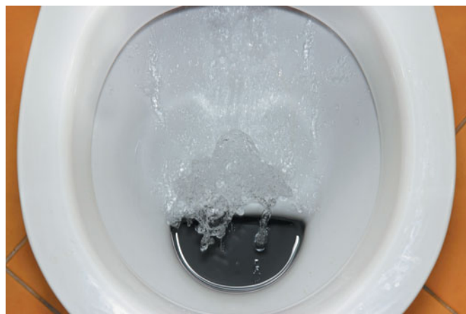
Тарельчатый унитаз представляет собой чашу с углублением. Сливное отверстие находится чуть выше дна чаши. Смыв такого унитаза требует много воды
