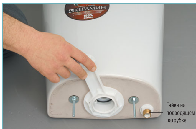
8 Специальным ключом откручиваем крепление сливного клапана и гайку на подводящем патрубке.
