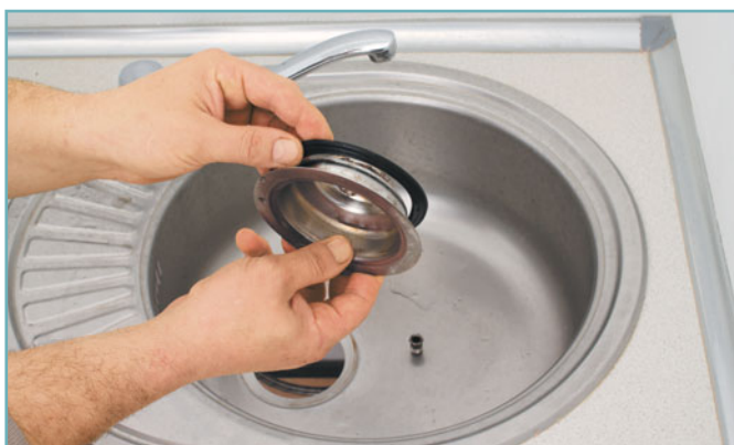
1 Надеваем на решетку уплотнительное кольцо дна сифона.
