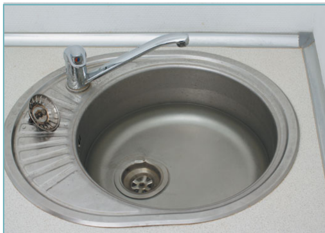
8 Открываем выпуск из мойки и проверяем внизу, на сифоне, нет ли течи.
