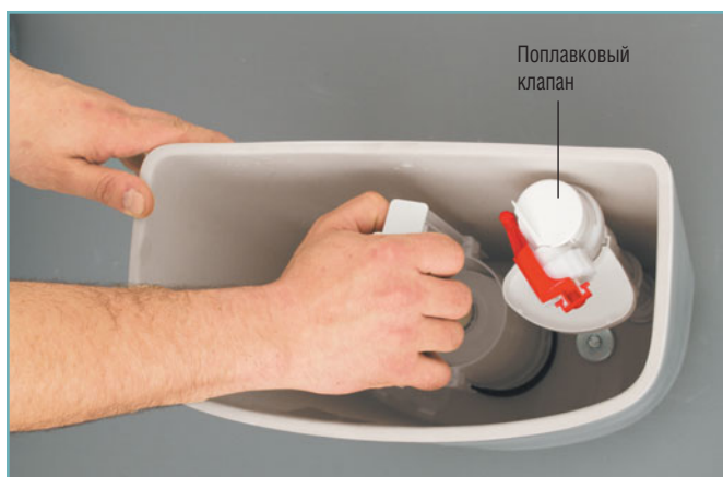
9 Вынимаем сливной клапан.
