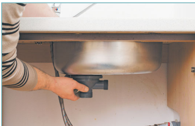
3 Придерживая верх сифона снизу, вкручиваем винт в гайку.
