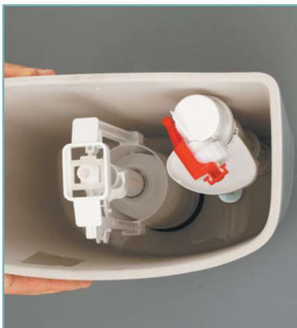
18 Бачок готов к монтажу на полку унитаза.
