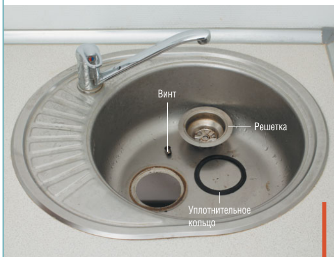
9 Выворачиваем винт, крепящий верх сифона с входными патрубками — центральным и боковым.
