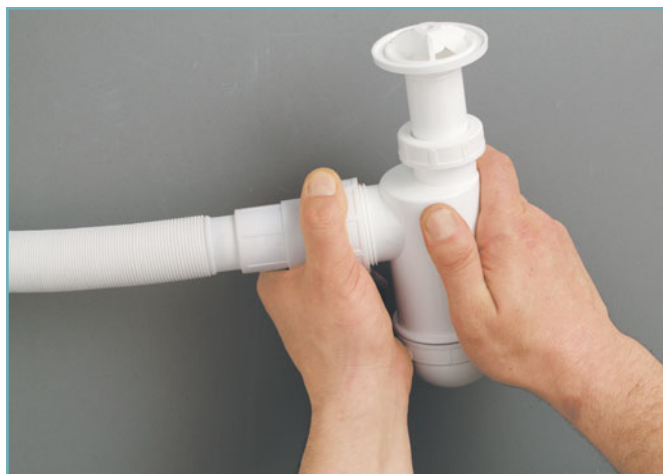
5 Затягиваем гайку до упора.
