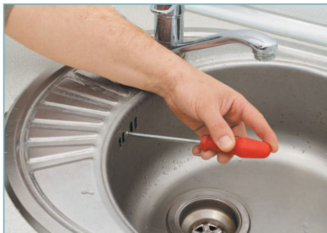
6 Откручиваем с помощью отвертки винт, крепящий переливную трубу.
