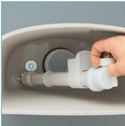
15 Вставляем поплавковый клапан в предназначенное отверстие.
