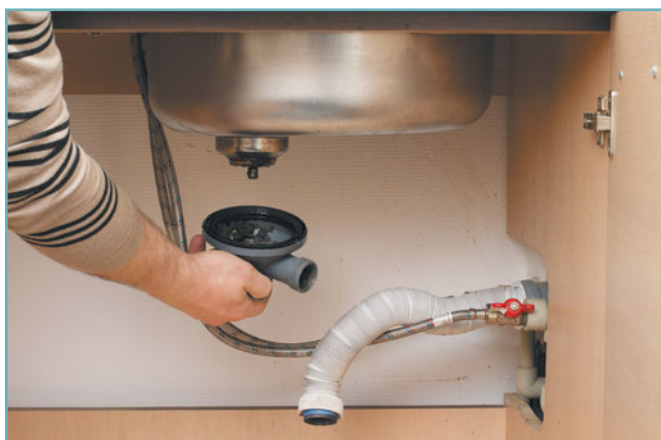
10 Снимаем верх сифона. Демонтаж произведен.
