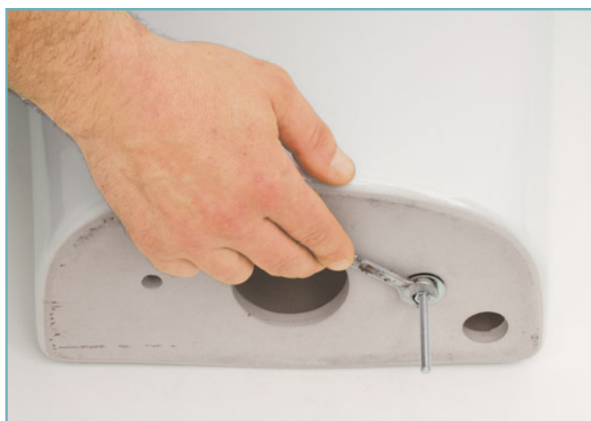
11 Выкручиваем винты крепления бачка к унитазу. Работа по демонтажу закончена — можно ставить новый бачок.
