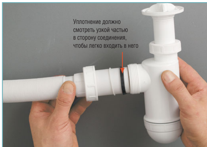
4 Подсоединяем выпускную трубу сифона.
