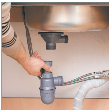
4 Подсоединяем собранный сифон к прикрученному к мойке верху сифона.
