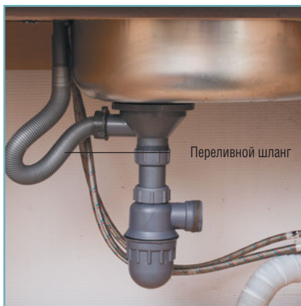
5 Подсоединяем переливной шланг.
