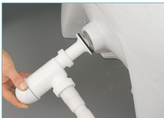
7 Осуществляем монтаж сифона в раковину, его необходимо поддерживать под днище.
