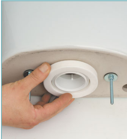
13 Прикрепляем уплотнительное кольцо к бачку.
