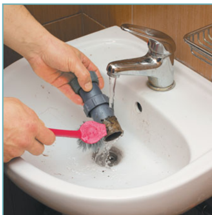
7 Промываем погружную трубку сифона изнутри и снаружи.
