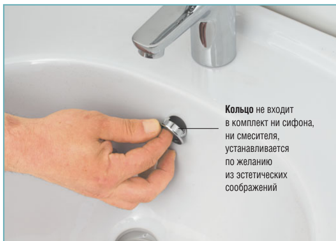
11 Устанавливаем в отверстие перелива декоративное кольцо-обрамление.
