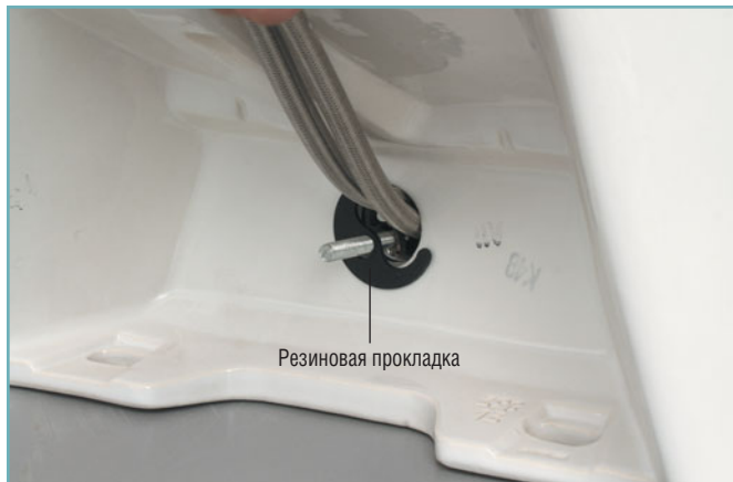
7 Надеваем на шпильку резиновую прокладку.
