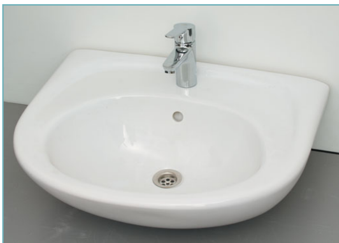
10 Устанавливаем решетку на сливе (обычно это делается при монтаже сифона).
