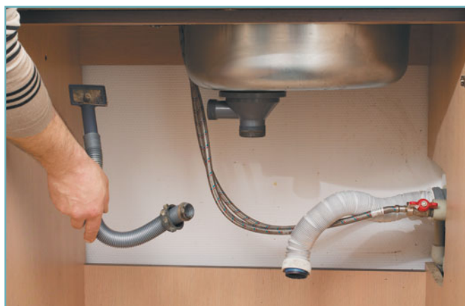
8 Отсоединяем переливную трубу.
