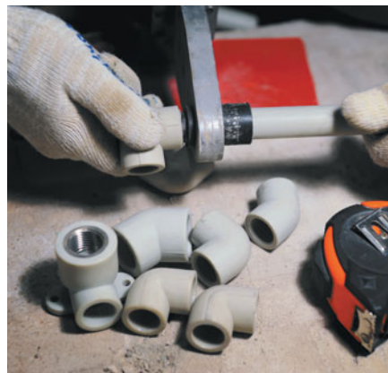
Полипропиленовые трубы и фитинги соединяют между собой сваркой
