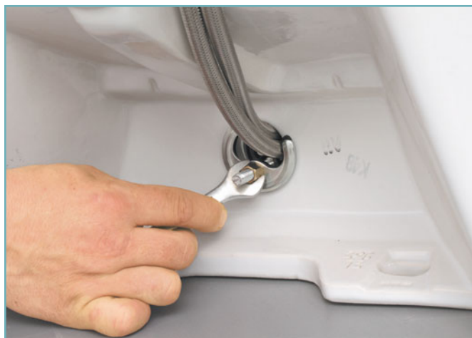
9 Закрепляем смеситель гайкой.
