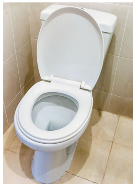
Козырьковый унитаз. Его сливное отверстие, как и у тарельчатого унитаза, расположено в передней части, однако к нему ведет покатая стена. Такая форма существенно облегчает слив
