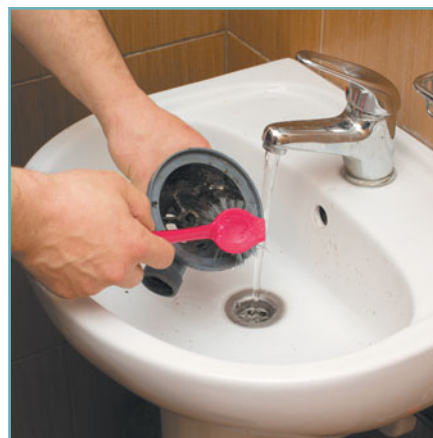
9 Прочищаем посадочное место уплотнительного кольца.
