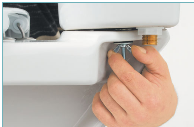
6 Откручиваем барашковые гайки крепления бачка к унитазу.
