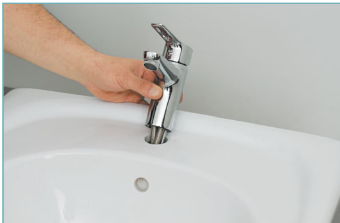
6 Устанавливаем смеситель на место.
