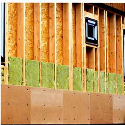
Стены каркасных домов утепляют матами из базальтовой ваты и зашивают снаружи плитами ОСП, после чего следуют слой фасадного утеплителя, гидроизоляционный слой и фасадный материал.
