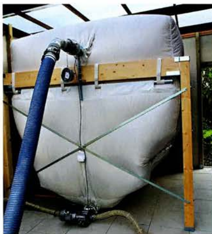
↑ Мягкий бункер-хранилище с пневмоподачей топлива.
