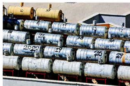
На крышах многоквартирных домов уже появляются солнечные коллекторы. Цифры на баках — это номера квартир.
