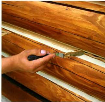
Герметики недавно применяют для изоляции швов сруба, но и они зарекомендовали себя с лучшей стороны. Единственная сложность иногда возникает с эстетикой исполнения такой работы — всё-таки не мох конопатить.
