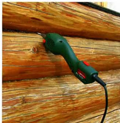
Как оказалось, для конопачения может пригодиться электростамеска с насаженным широким долотом. Отечественные мастера уже оценили этот способ.
