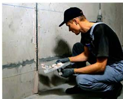
Полости, оставшиеся от маячковых реек, заполняют строительной смесью, а затем выравнивают и шпатлюют.
