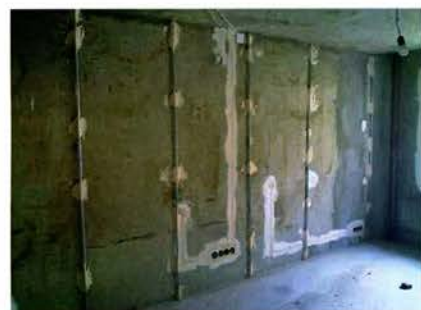
Вертикальные планки задают строгий отступ от стены, который будет заполнен раствором.
