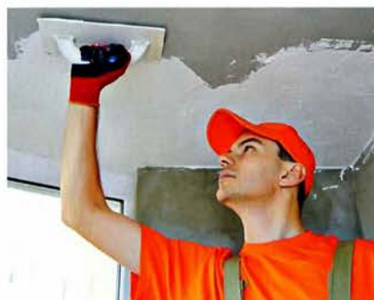
Заполнение выравнивающим составом.
