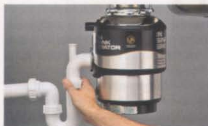
Подключение гидрозатвора к диспозеру и канализационной системе.
