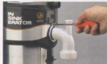
Подсоединение патрубка к диспозеру.
