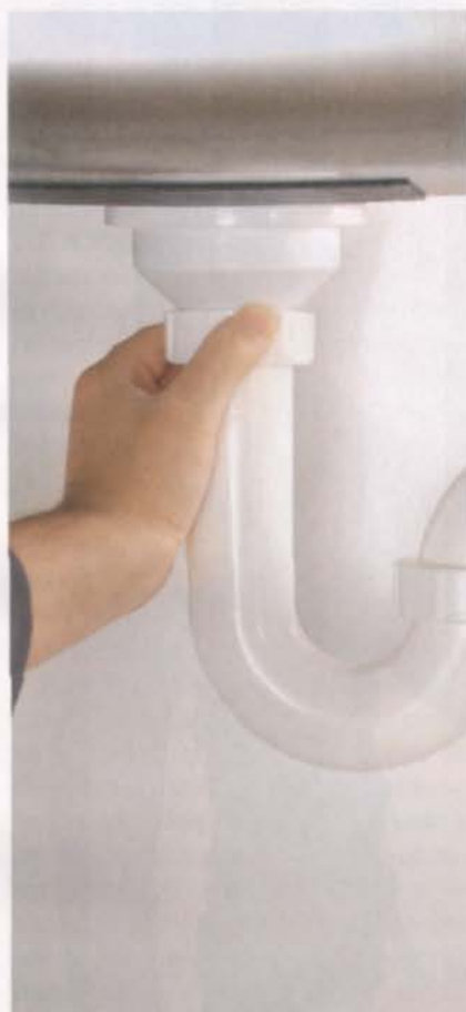
Демонтаж выпускного сифона — гидрозатвора.
