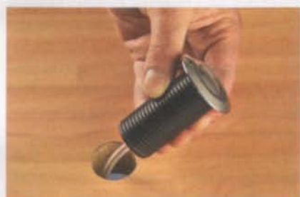
Установка пневмовыключателя на столешницу.
