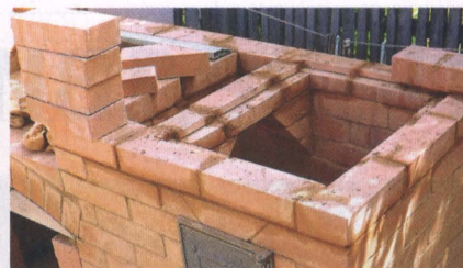
Для варочной плиты в кирпичах выбраны четверти.
