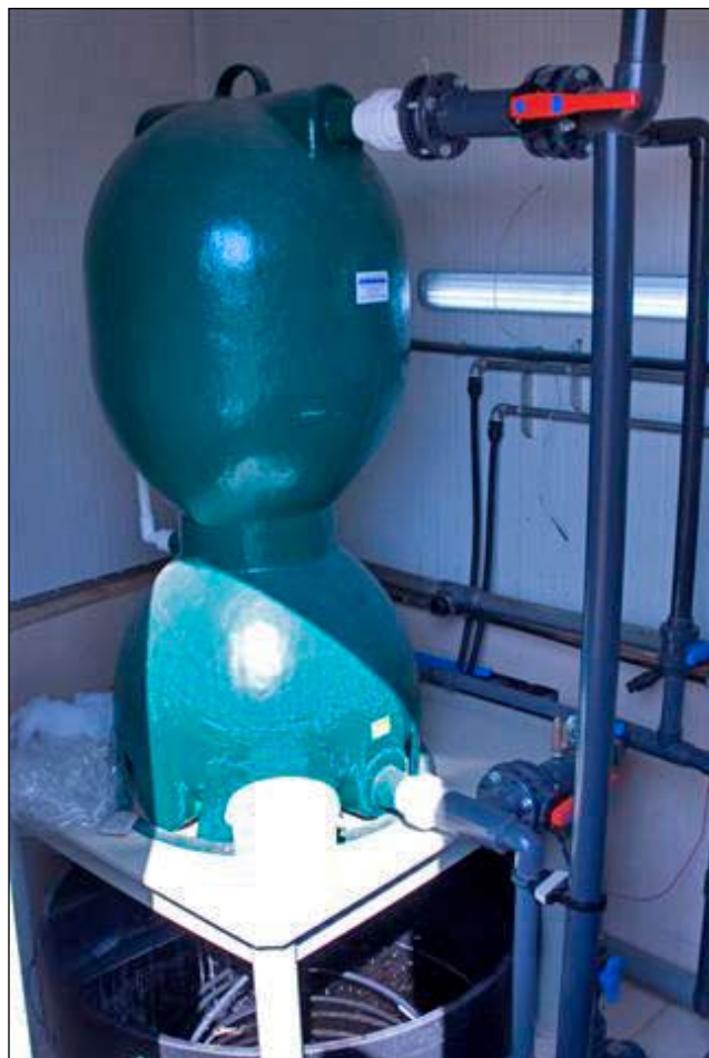
Фильтр, высотой метра полтора, в качестве наполнителя – пластиковые гранулы.
